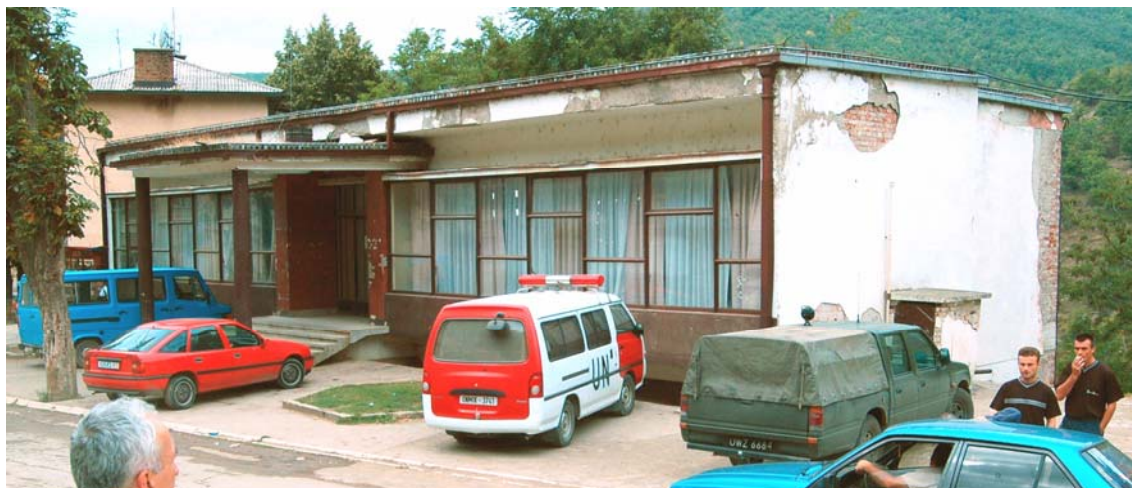
Photo 2 - La façade sud du musée et les dégradations les plus visibles de ce côté
